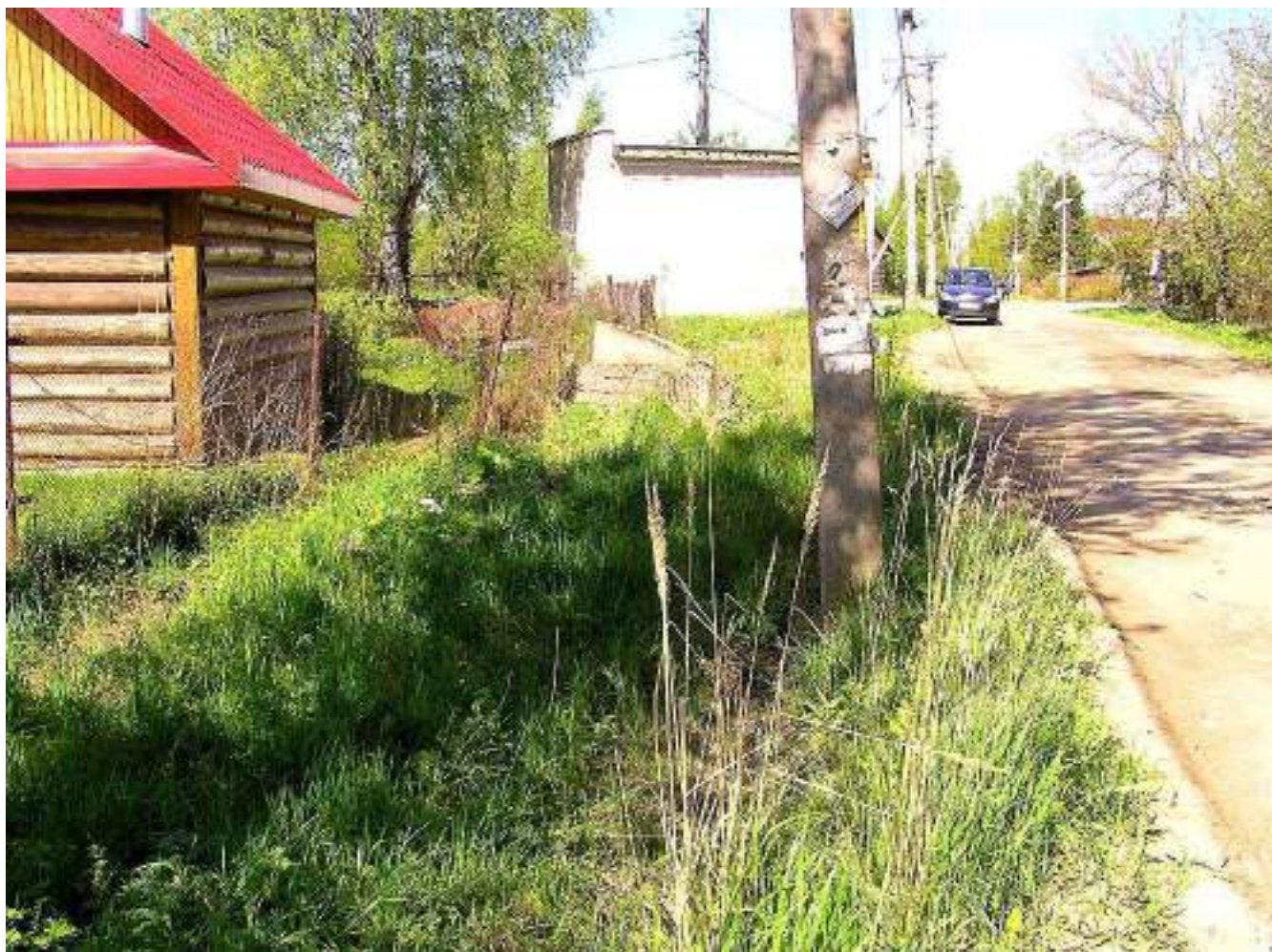
37. Саблино. Трансформаторная будка на углу пересечения Ульяновской дорожки и Ульяновского шоссе. Фото 2012 г.
